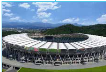
Shizuoka Stadium Ecopa Shizuoka Prefecture 小笠山総合運動公園エコパスタジアム 静岡県
